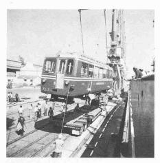
Talseitige Einheit eines elektrischen Zahnrad-Doppeltriebwagens Bhe 2/4 + 2/4 der Corcovado-Bahn in Rio de Janeiro, Brasilien, beim Verlad vom Schiff auf einen Strassen-Transportwagen
