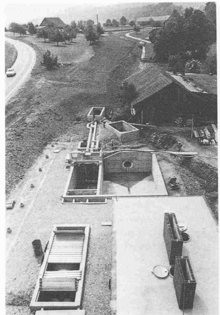
Die Kläranlage im Bau. Zu sehen sind auf der Decke des Faulraumes die beiden Lüftungskamine, die eine Gasansammlung unter dem Satteldach verhindern.
