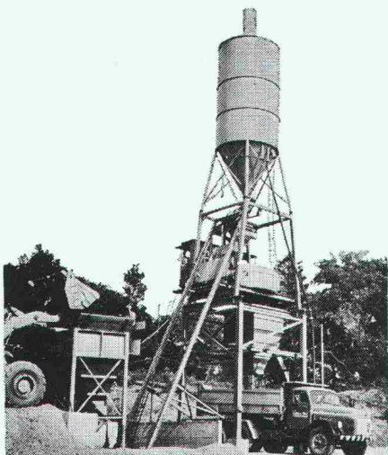
Standard-Betonanlagen AEBI, 4 Typen zwischen 20 m<sup>3</sup> und 60 m<sup>3</sup> Festbeton pro Stunde.
