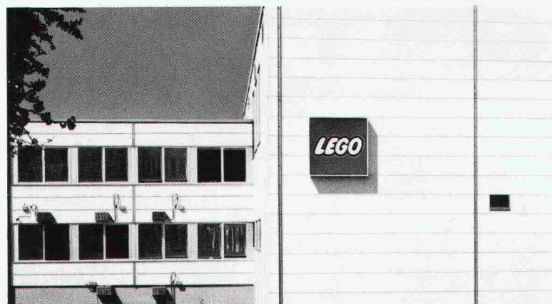
Das Montagebau-System mit Gasbeton-Elementen garantiert grösste Flexibilität auch bei späteren baulichen Vorhaben.
