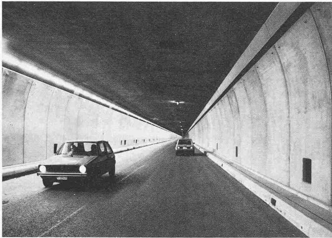
Tunnelnormprofil nach Abschluss der Innenausbauarbeiten
