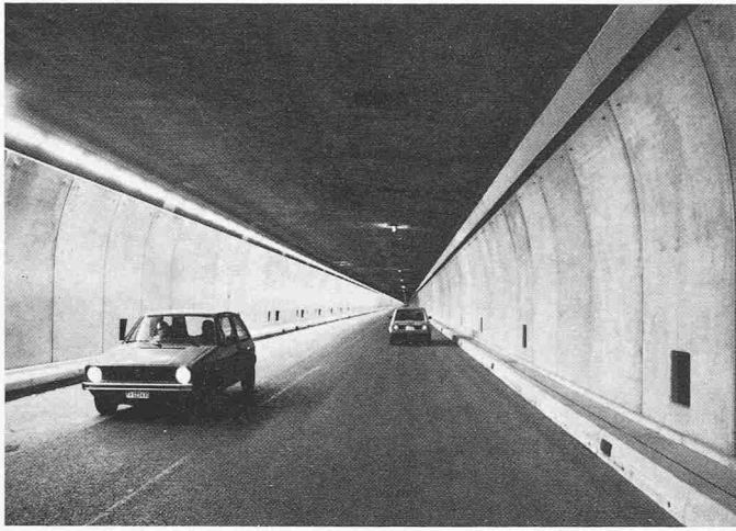
Tunnelnormprofil nach Abschluss der Innenausbauarbeiten
