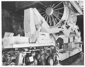
Montage eines Ventilators ab Spezial-Transporthebebühne in der unterirdischen Lüftungszentrale Motto die Dentro
