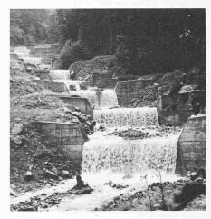
Oberlauf: Sohlenabtreppung im Haupterosionsgebiet Schlägtobel mit schlanken Eisenbetonsperren
