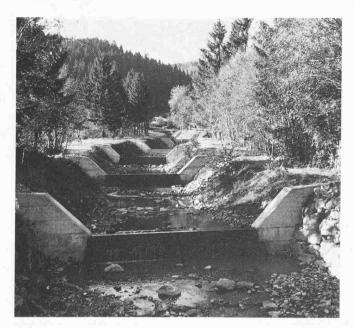
Mittellauf: Leichte Abtreppung mit Eisenbetonschwellen, Blockwurf, Bepflanzung und beidseitigen Unterhaltswegen
