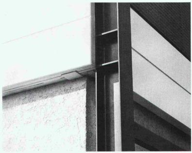
Nur Trockenbauweise gestattete eine Bauzeit von 3 Monaten. Deshalb für Fassaden, Boden und Dach Gasbeton-Elemente.
