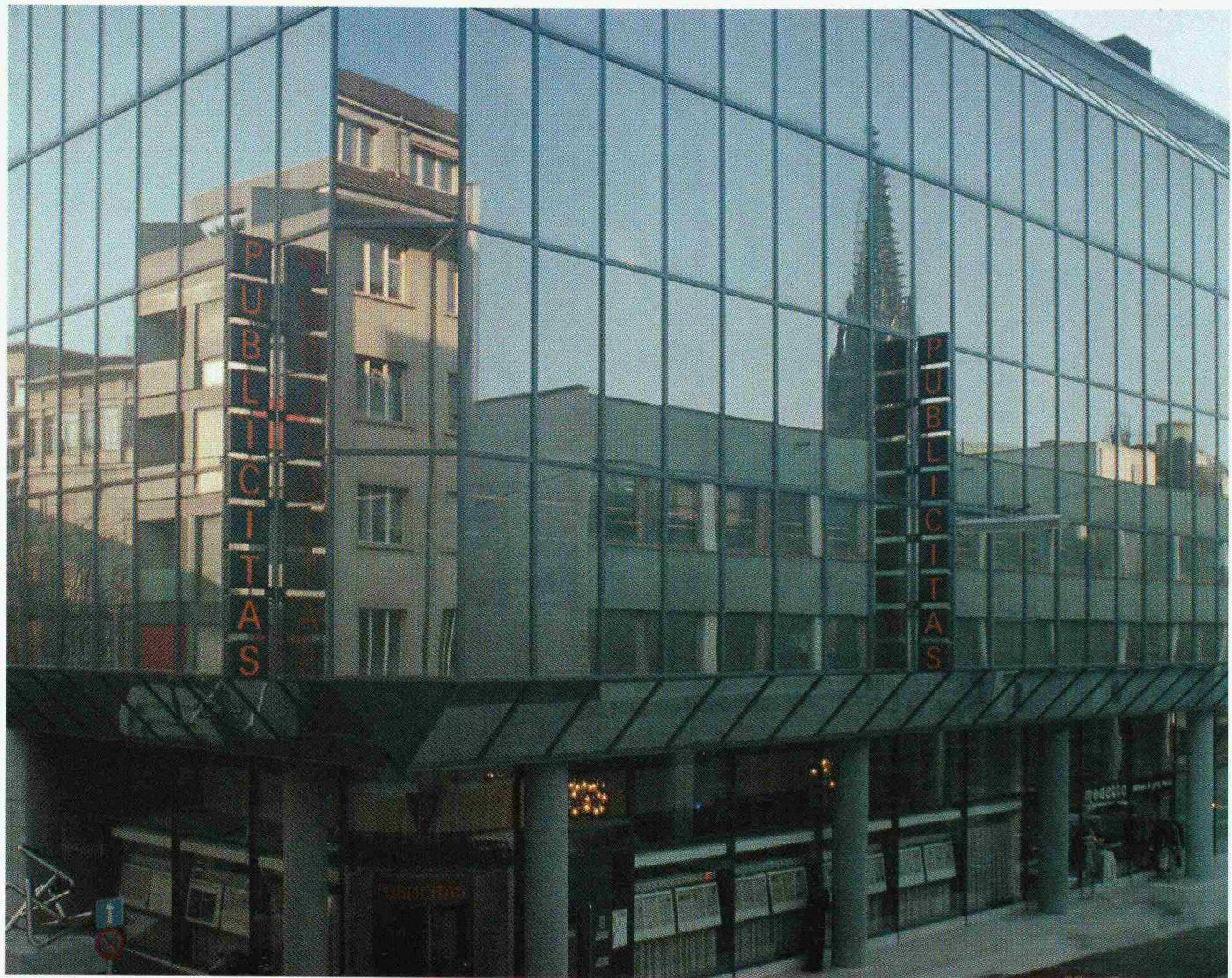
INFRASTOP - Sonnenschutz - Isoliergläser mit den hervorragenden k-Werten bis zu 1,4 W/m<sup>2</sup>K werden in allen Farbnuancen hergestellt, für hellspiegelnde farbakzentuierte Fassaden (in Ausresin, Gold, Bronze oder Silber) bis zu den Sonnenschutzfassaden ohne Reflexion und Farbwirkung (Grau oder Neutral). Die Konzeption grosszügiger Glasflächen bis zur Ganz-
