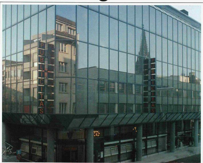
INFRASTOP - Sonnenschutz - Isolieraläser mit den hervorragenden k-Werten bis zu 1,4 W/m²K werden in allen Farbnuancen hergestellt, für hellspiegelnde farbakzentuierte Fassaden (in Ausresin, Gold, Bronze oder Silber) bis zu den Sonnenschutzfassaden ohne Reflexion und Farbwirkung IGrau oder Neutral). Die Konzeption grosszügiger Glasflächen bis zur Ganz-
