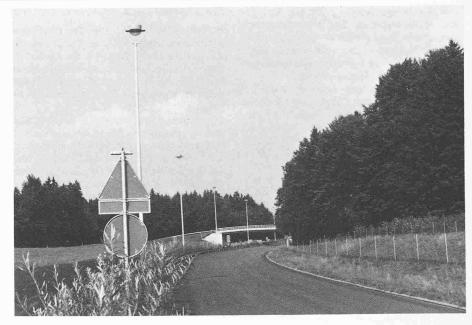
Bild 3. Beleuchtung entlang der Autobahn, Lichtpunkthöhe 15 m, Lichtpunktabstand 60 m
