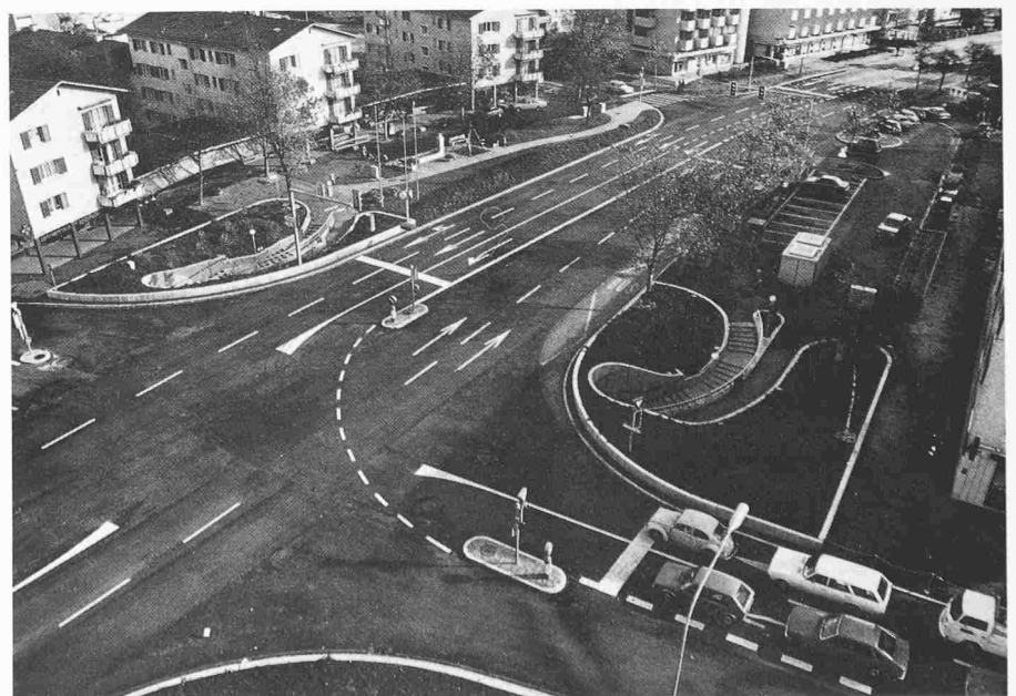
Zehntenhausplatz, vom Hochhaus nach Westen gesehen. Beim Ausgang links sieht man den Brunnen mit Linde, beim Ausgang rechts befinden sich die Bushaltestelle mit WC-Häuschen, Telefonkabine und Wartehalle
