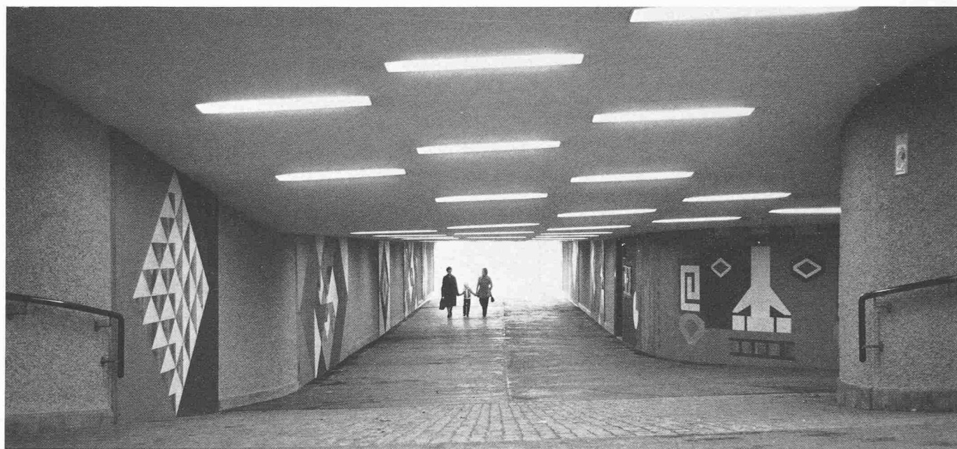
Personenunterführung Riedhaldenstrasse. Blick zum Nordausgang. Im Vordergrund gepflastertes Feld unter einem Beleuchtungsschwerpunkt
