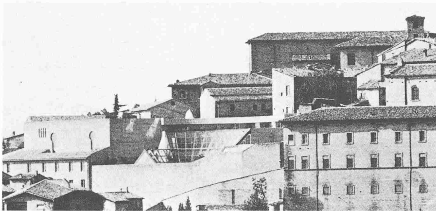
Lehrerseminar in Urbino. Integration durch Material und Proportion. Die notwendigen Beleuchtungsöffnungen sind zusammengefasst in einem grossen Oberlicht als Versatzstück der Gegenwartsarchitektur und einem Innenhof, der im Gesamtbild nicht in Erscheinung tritt; Einfügung ohne Kompromiss
