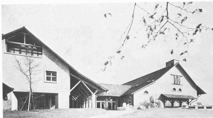
Gemeindeforum Utikon, 1978. Anpassung durch die Übernahme traditioneller Formen und Materialien. Aus der Rücksichtnahme auf bestehende Dorfbilder entstanden, beginnt sich diese Architektur bereits zu selbstständigen und schafft neue Idylle auch dort, wo es nichts anzupassen gibt
