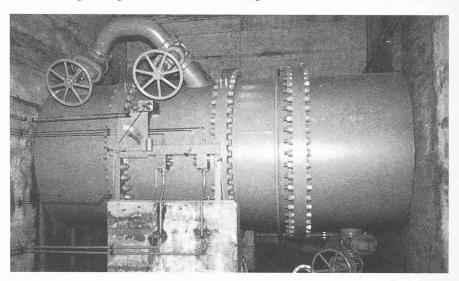
Drosselklappe Nr. 4 in eingebautem Zustand
