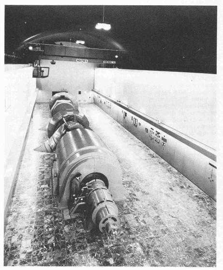
Maschinensaal im fertigen Zustand. Im Vordergrund: Maschinengruppe Isogyre. Im Hintergrund: Regulierbare Pumpe mit Antriebsmotor. Rechts: Steuertafeln für die örtliche Steuerung
