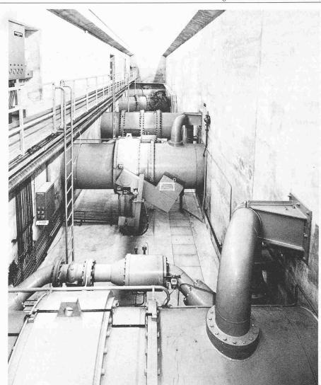
Bild 8. Schieberkammer mit Betriebsdrosselklappen
