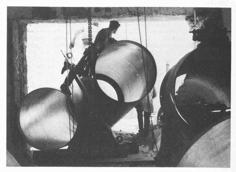
Für das Kraftwerk Küblis im Bündnerland wurden drei 57 bzw. 51 Jahre alte Druckleitungen durch eine einzige, grössere Leitung ersetzt. Durch eine Montageöffnung im Apparatehaus schieben Monteure ein sperriges Hosenrohr (Verzweigungsstück) zentimetergenau ein. Dank der neuen Druckleitung kann die Energieproduktion dieser Wasserkraftanlage wieder auf Jahre hinaus gesichert werden
