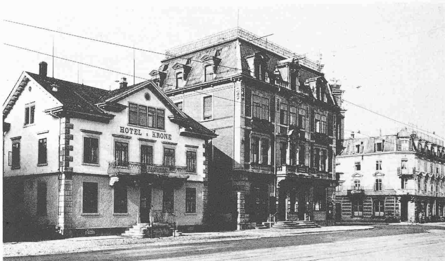
Uster, Bahnhofplatz. Östliche Platzhälfte mit Hotel «Krone» (1880) und Volksbank (1898). Antonio Bianchi errichtete verschiedene Bauten, so z. B. in der Mitte der Platzfront den üppig dekorierten Neubarockbau der Volksbank, der durch seine reiche Dekoration und die Integration der Bauplastik auffällt
