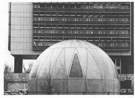
Bild 1. Das 8 m hohe Kugelhaus aus Kunststoff vor der Kulisse des Hochhauses der Abteilung Forschung und Entwicklung PTT in Bern-Ostermundigen
