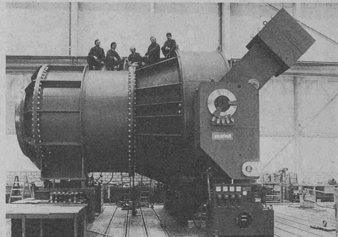
gebaut hat, sowie der bis heute weltweit grösste Ringschieber seiner Art fertiggestellt. Die beiden Absperrorgane, welche zusammen rund 100 Tonnen wiegen, sind für das Wasserkraftwerk Vangen am Sognefjord in Norwegen bestimmt. Die Absperrklappe (Nennweite
