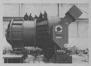
gebaut hat, sowie der bis heute weltweit grösste Ringschieber seiner Art fertiggestellt. Die beiden Absperrorgane, welche zu-sammen rund 100 Tonnen wiegen, sind für das Wasserkraftwerk Vangen am Sognefjord in Norwegen bestimmt.
