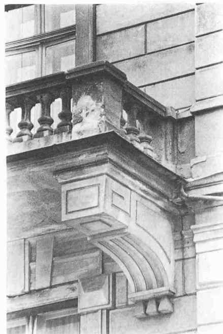
Verwitterungsschäden an Balkonen
