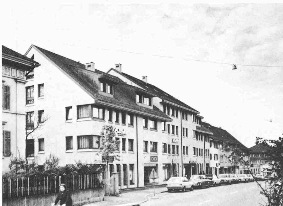
Die Neubauten von Norden aus der Kasernenstrasse
