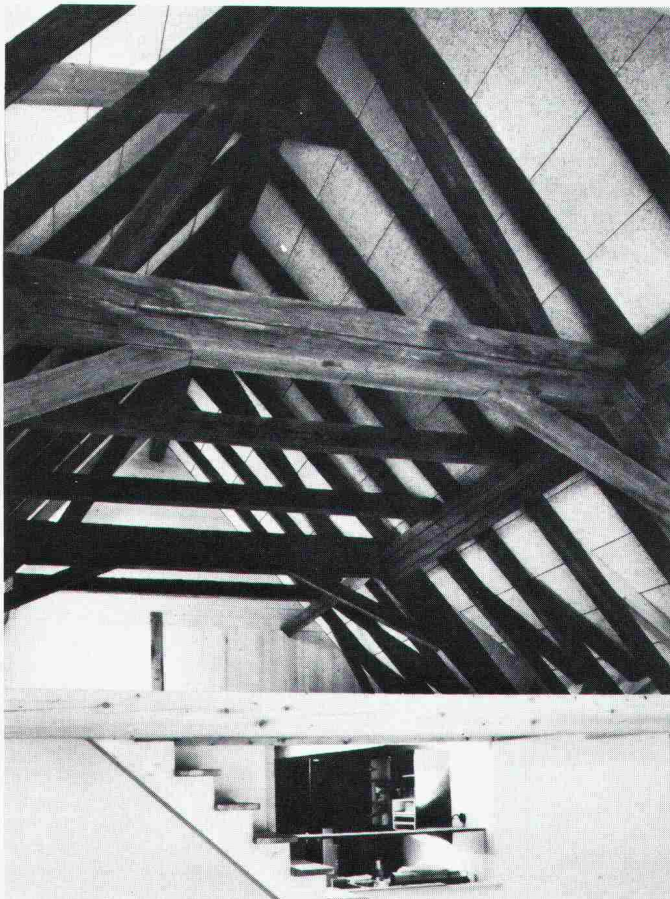
Schichtex Unterdach (Alte Mühle, 3054 Schüpfen). 600 m 2 Schichtex Spezial 75/III, mit Längsfalz, Sichtseite mit Dispersionsanstrich offen, auf Sparten montiert
