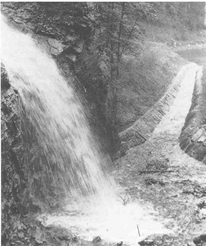
Der Wasserfall der Kleinen Saar und deren Ableitung in den Kiesfang des Saarfalles
