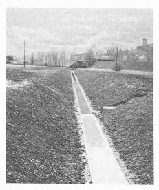
Neuer Vorflutgraben; zufolge geringen Gefälles war hier der Einbau einer Betonsohle nötig, während alle grösseren Kanäle bei entsprechendem Gefälle eine Kiessohle und eine Seitenpflästerung aus Natursteinen erhielten
