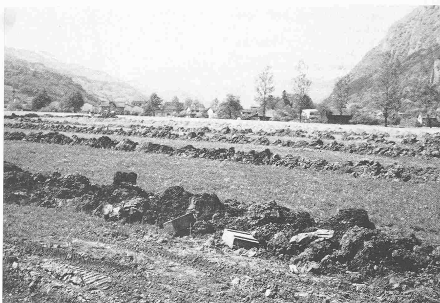
Entwässerungsgräben für die Detaildrainage
