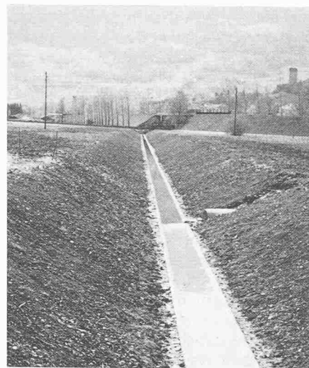
Neuer Vorflutgraben; zufolge geringen Gefälles war hier der Einbau einer Betonsohle nötig, während alle grösseren Kanäle bei entsprechendem Gefälle eine Kiessohle und eine Seitenpflasterung aus Naturstein erhielten
