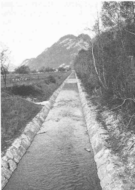
Der verbreiterte und vertiefte Saarableitungskanal, Kiessohle und Natursteinpflasterung unter Schonung des linksufrigen alten Baumbestandes
