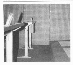
Zusätzlicher Schutz der Schallabsorptionsplatten in der meistgefährdeten Zone eines Schützenhauses durch ein Metallgitter
