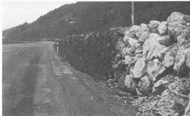
Bild 8. Abstützung einer durchnässten Strassenböschung mit einer Blockschichtung, mit Mulchsaat begrünt. 1 Jahr alt
