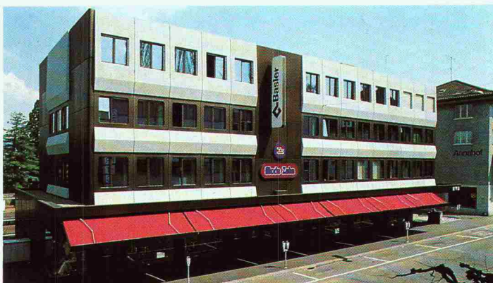
Geschäftshaus, CH-Thalwil, 1976 INFRASTOP-Auresin 39/28 Arch. G. Theiler, Thalwil
