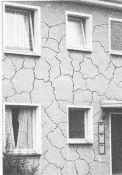
Bild 3. Spannungsrisse
