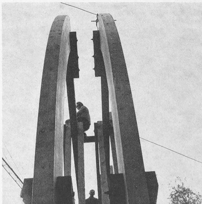
Bild 26. Zwei formgebende Elemente sind montiert
