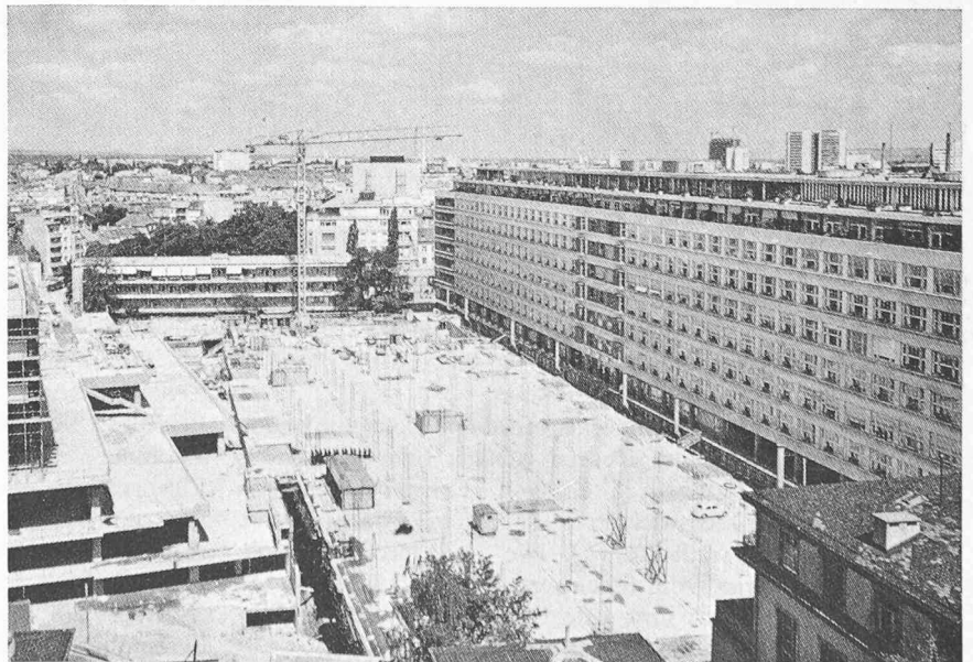
Bild 1. Vogelschau der Baustelle. Die grossflächige, fünfstöckige Tiefgarage liegt unmittelbar neben dem bestehenden Spitalgebäude. Die über die oberste Decke herausragenden vertikalen Spannstrangen dienen zum Absenken der darunterliegenden Decken
