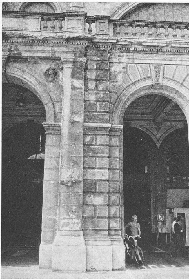
Bild 9. Restaurationsarbeiten am Hauptbahnhof Zürich. Abgesprengte Gurten, wegen durchgerosteten Abfallröhren durchnässter Pfeiler. Photo: Institut für Denkmalpflege, ETHZ
