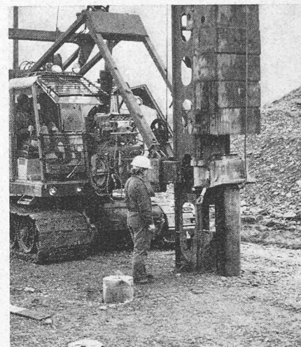
Bild 8. Rammen der Pfähle
