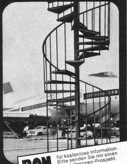
Nottreppe am neuen Fingerdock in Kloten
