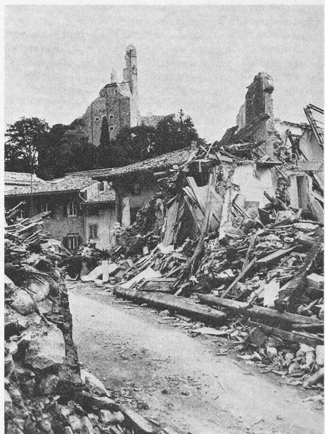
Bild 13. Ansicht des zerstörten mittelalterlichen Städtchens Gemona. Eingestürzte und beschädigte Häuser an der geräumten Strasse, im Hintergrund die Ruine des Burgturms
