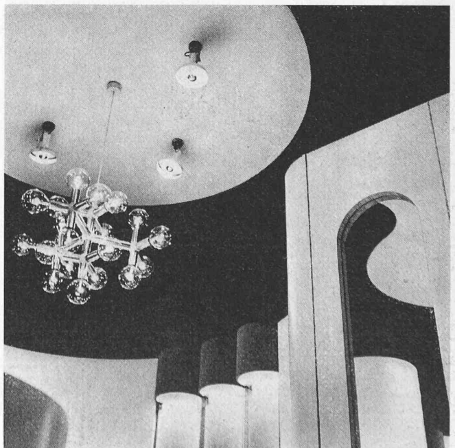
Embassy St. Moritz. Formenspiel von Wandelementen und Deckenschild. Hinter den freien Formen steht ein strenges Konzept von Sperrholz-Normelementen handelsüblicher Dimensionen (Leuchter aus der Produktion der Firma Swiss Lamps, Entwurf Heussmann)
