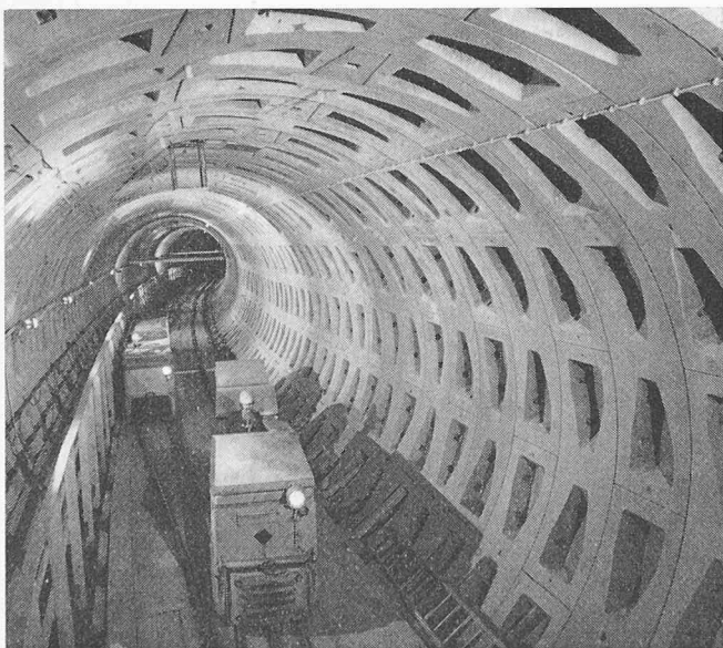
Bild 1 (links). Streckentunnel von Bild 2 im Bauzustand. Einschaliger Tunnelausbau mit Stahlbetontübbings
