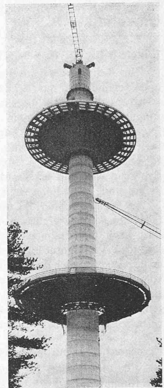
Bild 3 (rechts). Fernmeldeturm Wesendorf (FMT 14; 1970/71) während des Baus; 94 m hoher Schaft aus Kletterschalungsbeton mit einer Kanzel und drei Plattformen.
