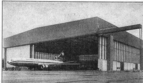
Flugzeughalle von 16 000 m<sup>2</sup> Überdeckung mit Rolltoren von 26 m Höhe
