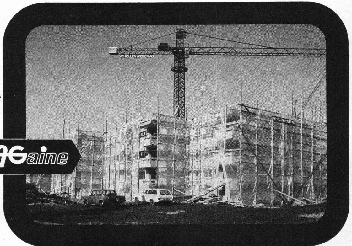
Howagaine-Folien sind durchsichtig, isolierend und säurebeständig. Sie eignen sich auch vorzüglich für provisorische Schutzdächer bei Umbauten, für Fensterabschlüsse bei Rohbauten, zur Abschirmung von wertvollem Baumaterial, als Abdeckmaterial bei Strassenbauten, für Trennwände und Schallisolationen beim Betonieren, für Barackenbauten usw.
