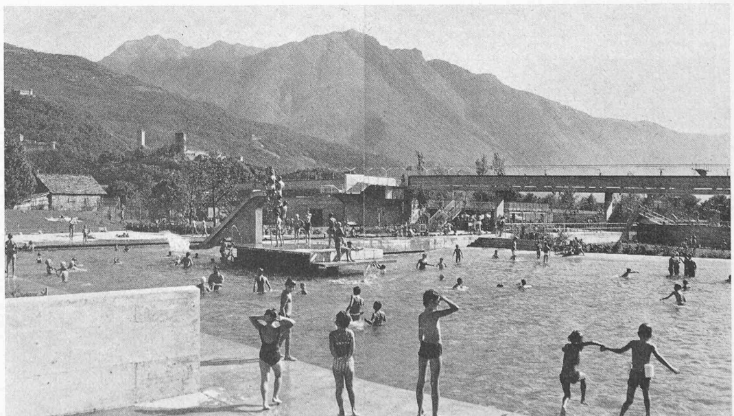
Becken für Nichtschwimmer (Lernschwimmbekken) mit Rutschbahn. Jenseits der Passerelle das Schwimmbecken (Olympia-Becken)
