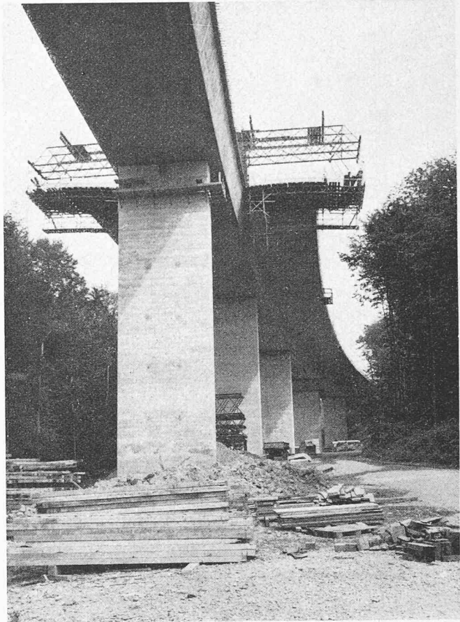
Bild 5. Bau der Randabschnitte auf einem Lehrgerüst
