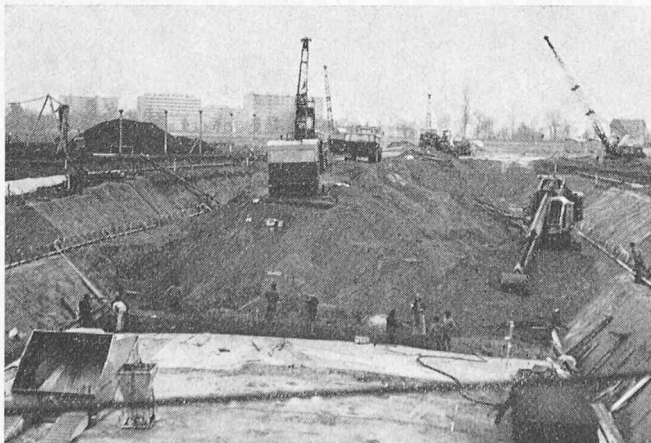
Bild 7. Blick von der Hilfsbrücke gegen E
