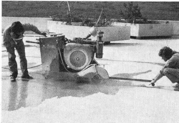
Auf dem Flachdach eines grossen Bürogebäudes muss eine Blitzschutzanlage montiert werden. Dafür fräste bft 80 m lange, 8 cm tiefe und 10 mm breite Fugen in die Betondecke. In nur einem halben Tag. Ohne Lärm, ohne Staub, ohne Erschütterung – millimetergenau.
