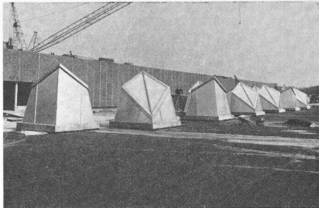
Dachoblichter über der Mall. Durch ihre Anordnung wird das Licht von verschiedenen Richtungen eingefangen
