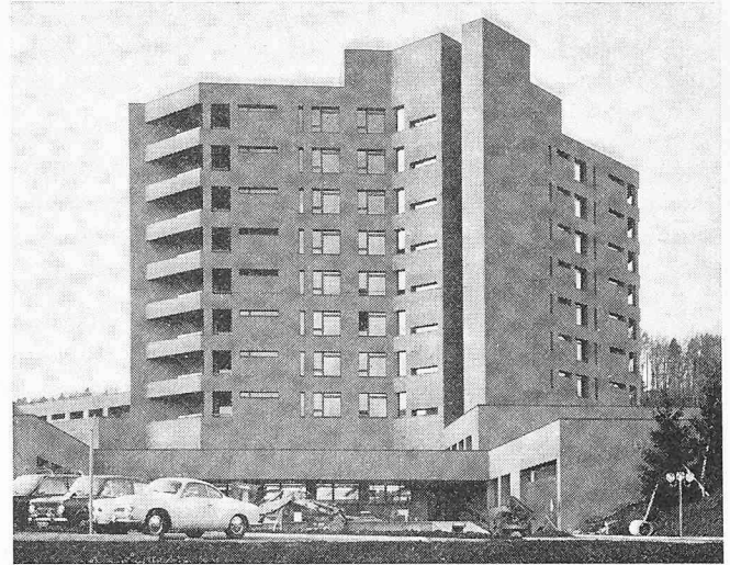
Bettenhaus von Südosten mit Wirtschaftshof
