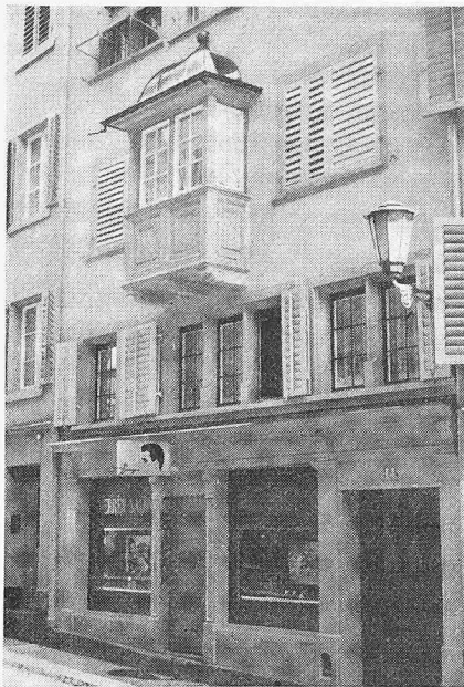
Das durch die Stadt gediegen renovierte Haus Nr. 14. (Schade: das störende Figaro-Schild!)
