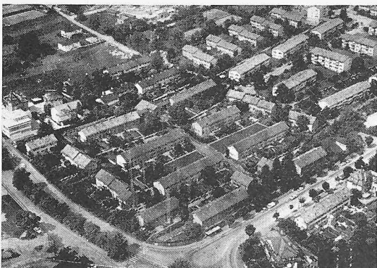
Unten: Die alte 1927 erbaute Kolonie «Utohof» umfasste 83 zweigeschossige Einfamilienhäuser
