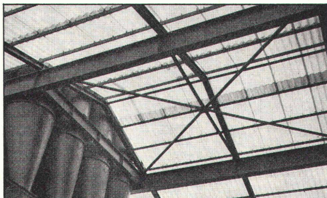
Neomat-Lichtdach auf einer Siloanlage
