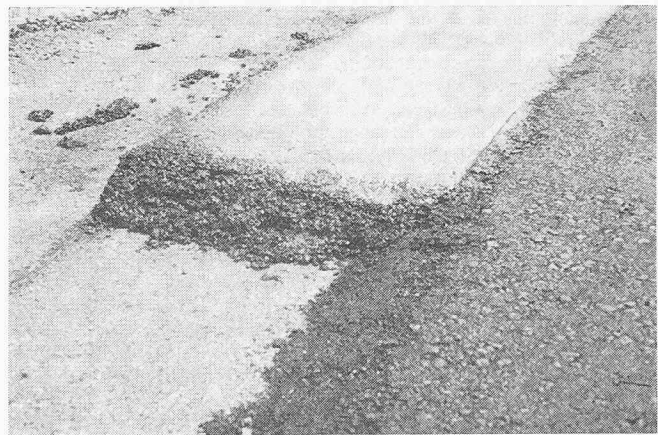
Bild 5. Einbau der am Aussenrand der HMT situierten ölbeständigen und plastischen Knautschzone
