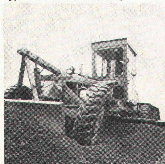
WAKEFIELD Motor Grader mit Frontschild und Aufreisser, Typen 5 t bis 13 t
