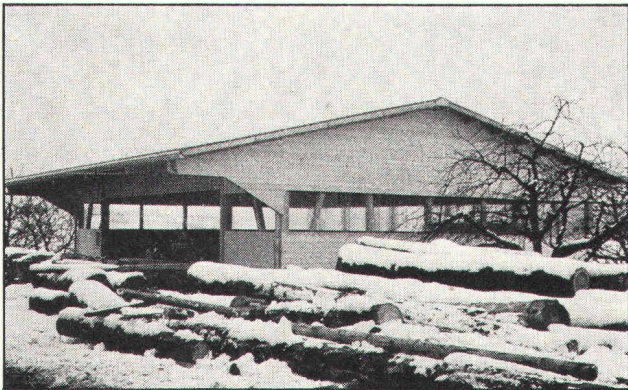
Lichtband bei einem Holzverarbeitungsbetrieb
