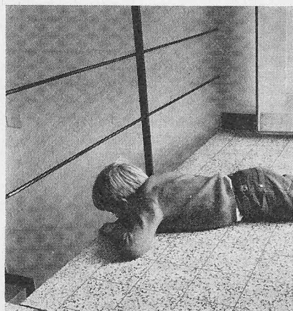
Bild 2. Der vierjährige Knabe betrat in Begleitung seiner Mutter das Treppenhaus, stolperte aber auf der Türschwelle, kam zu Fall und rutschte unter dem Geländer hindurch. Er stürzte in freiem Fall 12 m in die Tiefe
