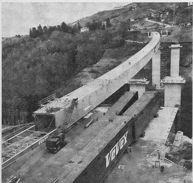
Ponts sur la Veveyse au-dessus de Vevey, N. 9 Autoroute du Léman. Deux ponts parallèles, en courbe, R = 900 m. Portées: 111+129+58 m. Par pont: une poutre métallique, en caisson quasi rectangulaire de 6 \times 5 m. Dalles coulées sur place sur coffrages mobiles et précontraintes transversalement. (Voir P. Preisig : Die Autobahnbrücke über die Veveysse. «Schweizerische Bauzeitung» No 18 du 1er mai 1969, p. 340 à 341)
