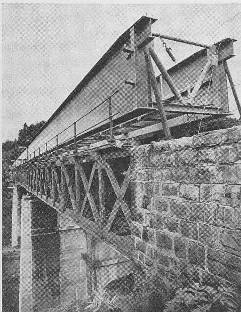
Pont CFF sur la Mionnaz près de Palézieux, ligne de chemin de fer Lausanne-Berne. Remplacement d'un ancien pont métallique rivé, à treillis, par un nouveau pont en construction mixte avec poutres métalliques en I et auge en béton armé supportant le ballast de la voie. La construction métallique a été d'abord montée au-dessus de l'ancien pont avant destruction de celui-ci. L'auge est formée d'éléments préfabriqués en usine, et précontraints longitudinalement après pose, par câbles et par abaissement des poutres sur piles. Portées: 34+43+34 m
