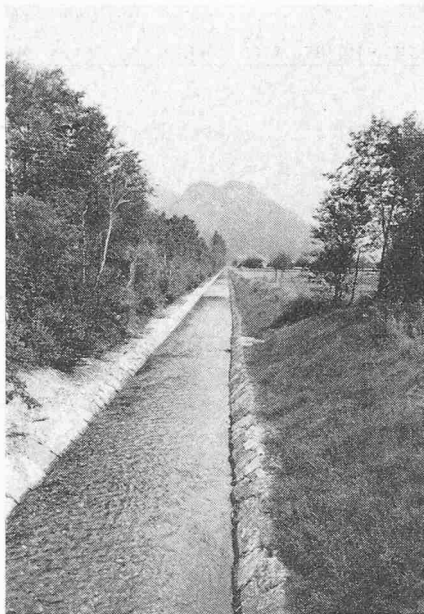
Bild 3. Korrigierter Saarkanal. Die linksufrige bestehende Bepflanzung wurde bei den Bauarbeiten geschont
