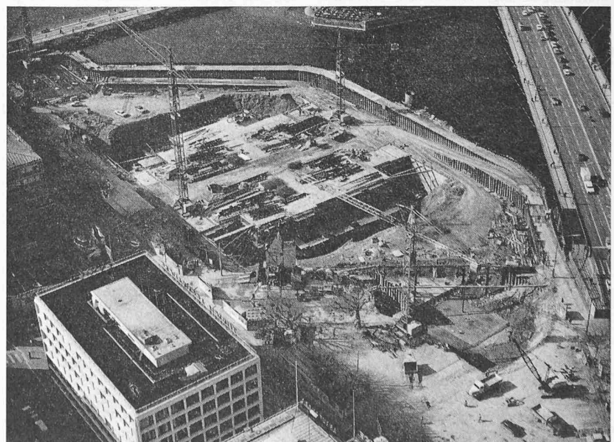
Luftbild der Bauarbeiten an der Unterwasser-Parkgarage in Genf
