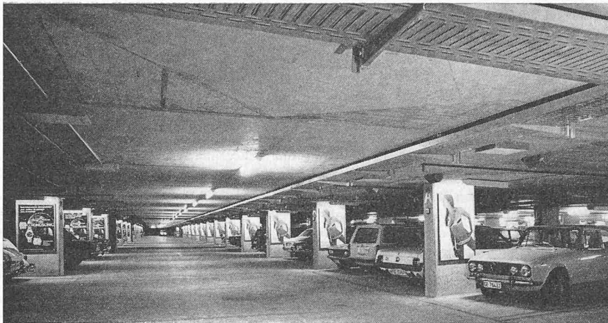
Gesamtansicht einer Etage der fertigen Unterwasser-Parkgarage in Genf
